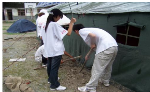
上图为 楼房队队员冒雨挖排水沟
